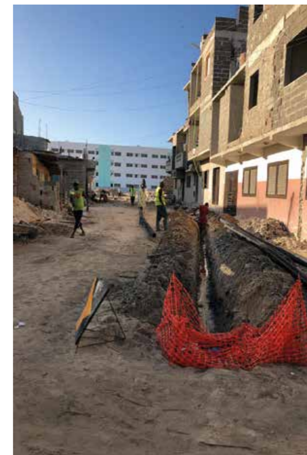
FIGURA 58. INSTALAÇÃO DE INFRAESTRUTURA NO BAIRRO DA BOA ESPERANÇA, SAL REI, ILHA DA BOA VISTA
