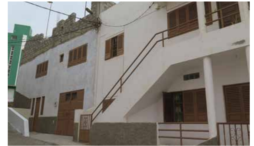
FIGURA 63.1. MORADIA EM CONSTRUÇÃO EVOLUTIVA COM ESCADA EXTERNA COM ACESSO SEPARADO PARA O SEGUNDO PISO, ESPARGOS, ILHA DO SAL. FONTE: ONU-HABITAT
