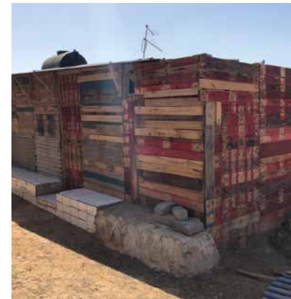
FIGURA 71. CONSTRUÇÃO EM MADEIRA NUM ASSENTAMENTO INFORMAL NÃO CONSOLIDADO
