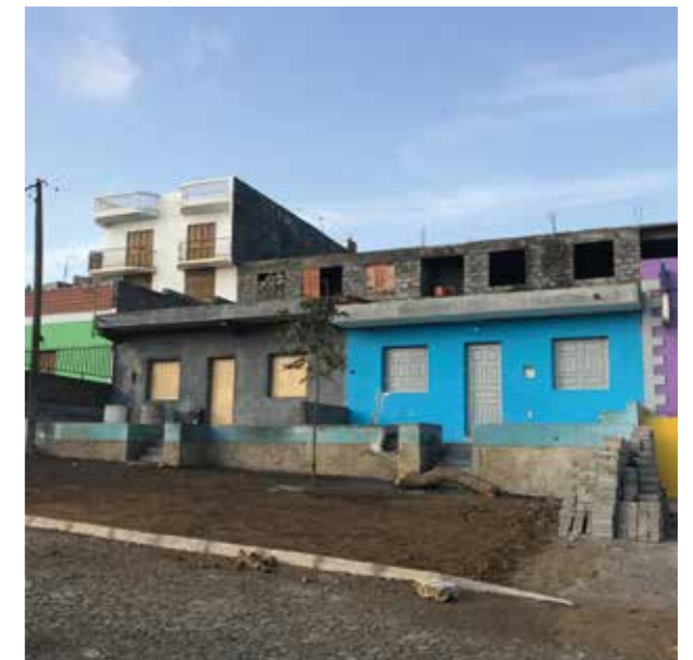
FIGURA 65.5. CASA TRADICIONAL, PORTO NOVO, ILHA DE SANTO ANTÃO. FONTE: ONU-HABITAT
