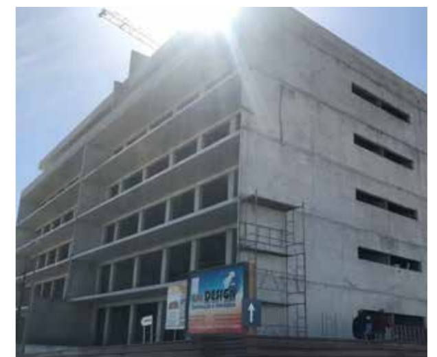
FIGURA 65.6. EDIFÍCIO DE APARTAMENTOS EM CONSTRUÇÃO. FONTE: MIOTH
