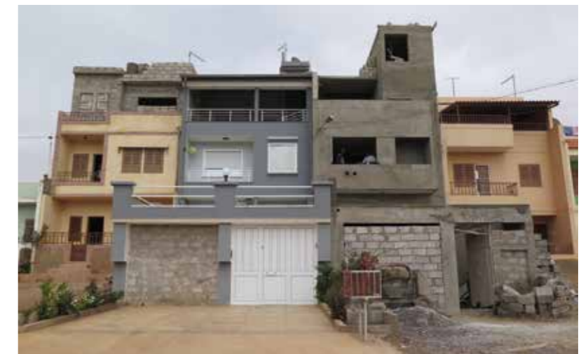
FIGURA 63.2. CONSTRUÇÃO INCREMENTAL NA VERTICAL, MINDELE, ILHA DE SÃO VICENTE. FONTE: ONU-HABITAT
