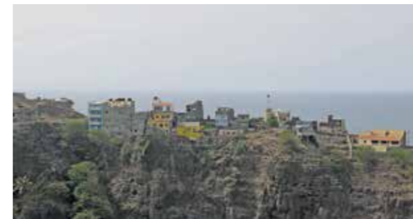
FIGURA 43.2. CONSTRUÇÃO EM TERRENO ACIDENTADO NA RIBEIRA GRANDE, ILHA DE SANTO ANTÃO. FONTE: ONU-HABITAT
