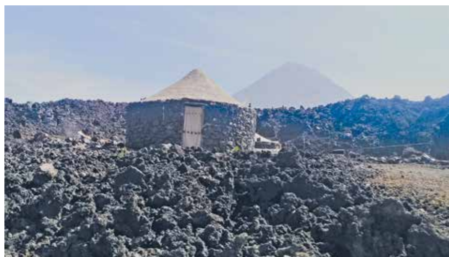
FIGURA 61.1: CONSTRUÇÃO TRADICIONAL EM PEDRA NA LOCALIDADE DE CHÃ DAS CALDEIRAS, ILHA DO FOGO. FONTE: MIOTH
