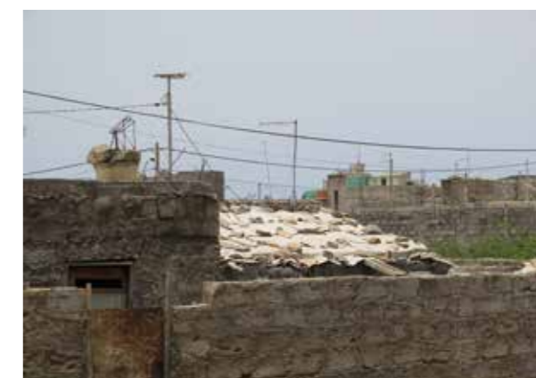
FIGURA 70. USO DE PEDRAS PARA DIMINUIR EROSIÃO, PORTO NOVO, ILHA DE SANTO ANTÃO
