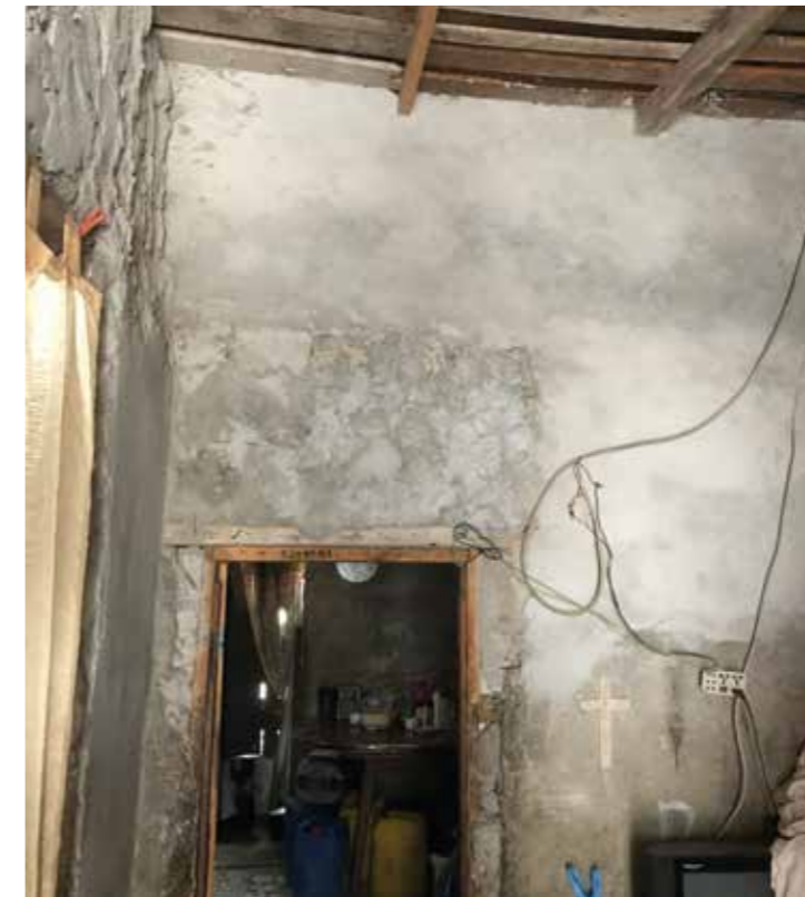
FIGURA 25.1. CONDIÇÕES DE PAREDES E REVESTIMENTO. FONTE: ONU-HABITAT
