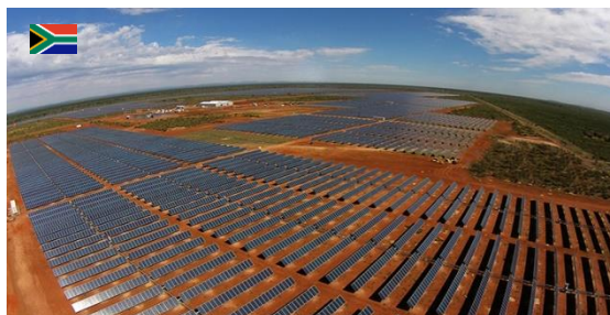
Ilustración 14: Planta solar Sishen
