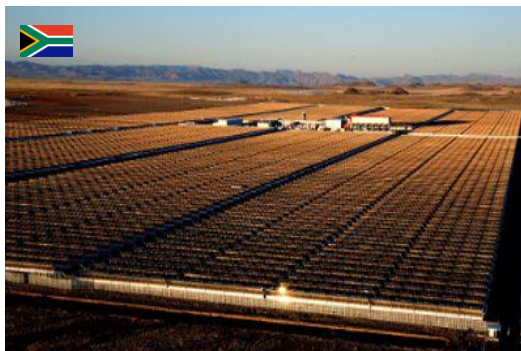
Ilustración 18: Planta KaXu Solar One
